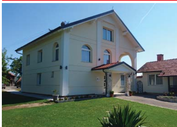
20 Jubizol Silicone finish S 2,0 mm nijansa N10F i nijansa 1001 bijela (Ugljevik)
